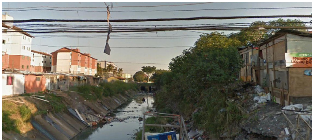
Figura 1.8. Ocupações precárias recentes em ZEIS pós 2014. Fonte: Google Street View
