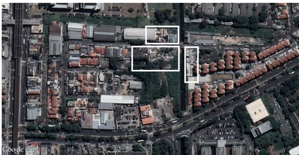
Figura 1.9. Ocupações precárias recentes em ZEIS pós 2014. Fonte: Google Street View
