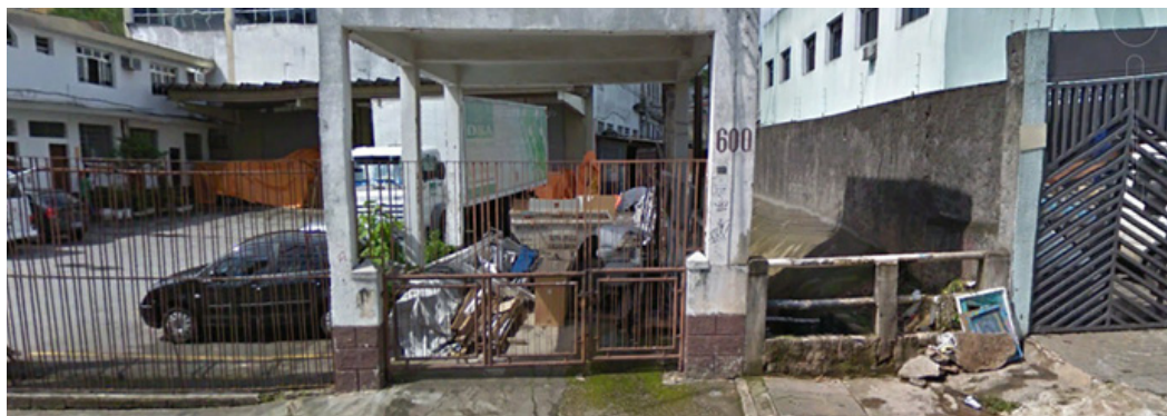
Figura 2.6: Córrego entre Mandaqui/Ten. Rocha, canal aberto, altura da R. Carandai, 600. Fonte: Google Earth, acesso 4 jan 2016.
