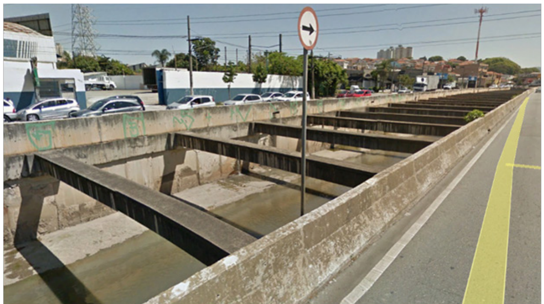
Figura 2.8: Av. Engº Caetano Álvares, córrego Mandaqui em canal aberto no canteiro central. Fonte: Google Earth. Acesso 23 dez 2015.
